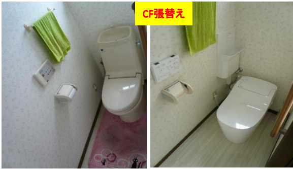
CF・壁張替え 薄型手洗い器に交換
